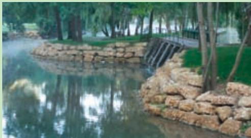
Les travaux ont été réalisés en juillet : protection contre l'érosion, enrochement des berges 140 tonnes de pierres - Coût de l'opération : 17 000 €.
