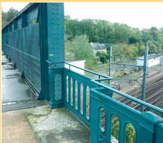
Ouvrage de 328 mètres de long et de 20 mètres de haut, le viaduc de Saint-Benoît a été construit fin 1800 afin de permettre la circulation du tramway sur la ligne départementale Poitiers-Saint Martin l'Ars. Désormais ouvert à la circulation piétonne, il était devenu nécessaire d'effectuer des travaux de mise aux normes en matière de sécurité du public.
